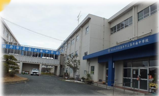
3年間通った学び舎：袋井南中学校
